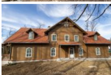
• 2024-03-29-Remont willi Anioł na finiszu
