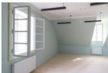
2024-03-29-Remont willi Anioł na finiszu
