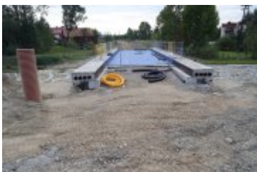
• 2024-09-19- Przejazd kolejowy w przebudowie
