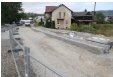
• 2024-09-19- Przejazd kolejowy w przebudowie
