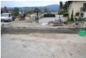
• 2024-09-19- Przejazd kolejowy w przebudowie
