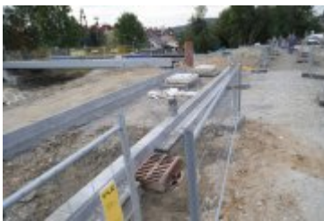
• 2024-09-19- Przejazd kolejowy w przebudowie
