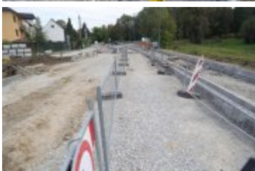
• 2024-09-19- Przejazd kolejowy w przebudowie
