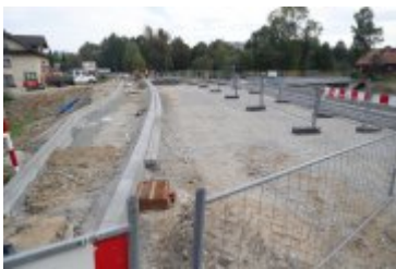
• 2024-09-19- Przejazd kolejowy w przebudowie
