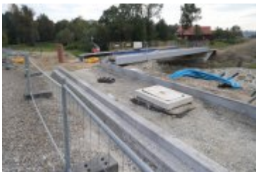
• 2024-09-19- Przejazd kolejowy w przebudowie
