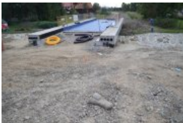
• 2024-09-19- Przejazd kolejowy w przebudowie
