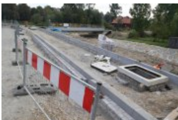
• 2024-09-19- Przejazd kolejowy w przebudowie
