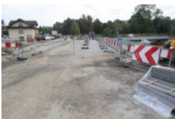
• 2024-09-19- Przejazd kolejowy w przebudowie
