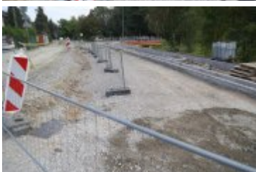
• 2024-09-19- Przejazd kolejowy w przebudowie
