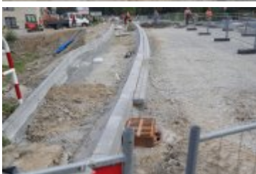
• 2024-09-19- Przejazd kolejowy w przebudowie
