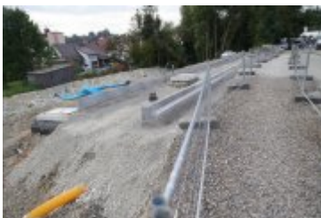
• 2024-09-19- Przejazd kolejowy w przebudowie
