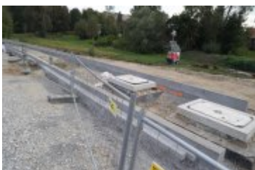
• 2024-09-19- Przejazd kolejowy w przebudowie
