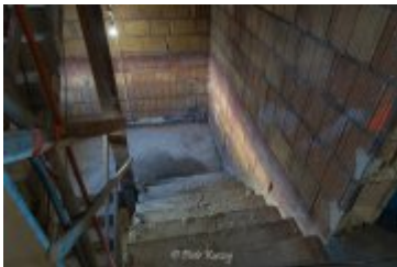
• 2025-02-10- Budowa bloku SIM na ul. Kilińskiego
