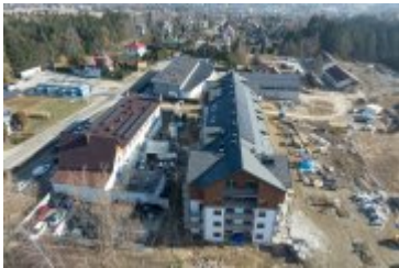
• 2025-02-10- Budowa bloku SIM na ul. Kilińskiego
