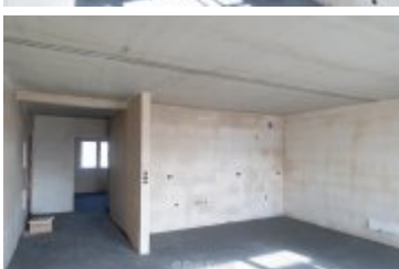
• 2025-02-10- Budowa bloku SIM na ul. Kilińskiego
