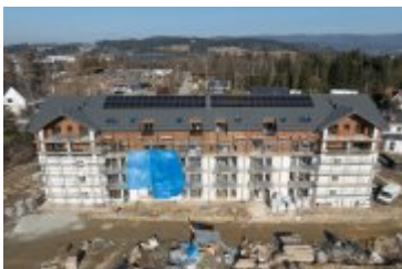
• 2025-02-10- Budowa bloku SIM na ul. Kilińskiego
