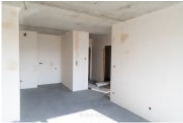
• 2025-02-10- Budowa bloku SIM na ul. Kilińskiego
