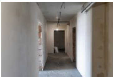
• 2025-02-10- Budowa bloku SIM na ul. Kilińskiego
