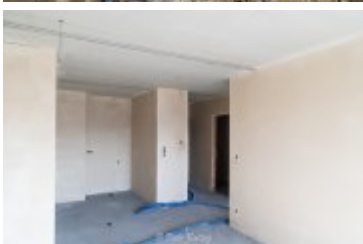
• 2025-02-10- Budowa bloku SIM na ul. Kilińskiego
