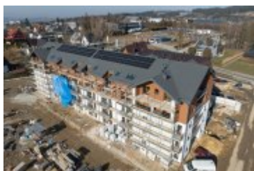
• 2025-02-10- Budowa bloku SIM na ul. Kilińskiego
