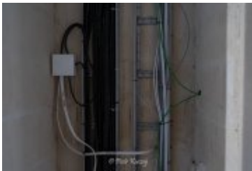
• 2025-02-10- Budowa bloku SIM na ul. Kilińskiego
