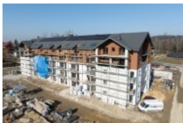
• 2025-02-10- Budowa bloku SIM na ul. Kilińskiego
