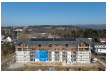
• 2025-02-10- Budowa bloku SIM na ul. Kilińskiego
