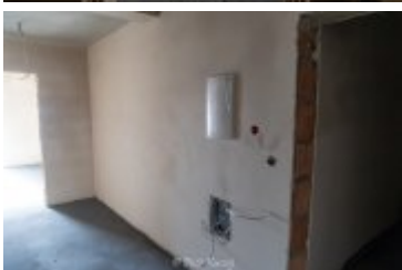
• 2025-02-10- Budowa bloku SIM na ul. Kilińskiego
