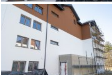
• 2025-02-10- Budowa bloku SIM na ul. Kilińskiego
