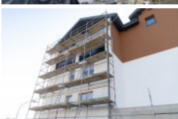
• 2025-02-10- Budowa bloku SIM na ul. Kilińskiego
