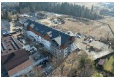
• 2025-02-10- Budowa bloku SIM na ul. Kilińskiego
