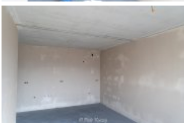
• 2025-02-10- Budowa bloku SIM na ul. Kilińskiego
