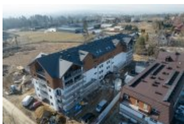
• 2025-02-10- Budowa bloku SIM na ul. Kilińskiego
