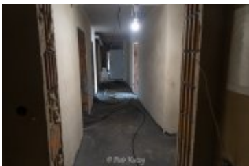
• 2025-02-10- Budowa bloku SIM na ul. Kilińskiego
