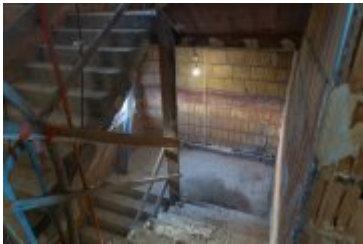
• 2025-02-10- Budowa bloku SIM na ul. Kilińskiego
