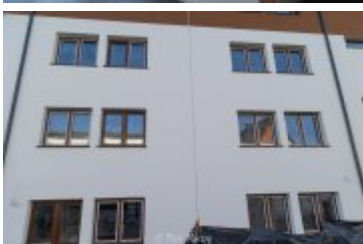
• 2025-02-10- Budowa bloku SIM na ul. Kilińskiego
