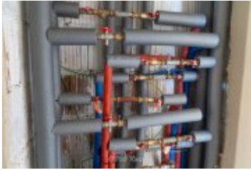
• 2025-02-10- Budowa bloku SIM na ul. Kilińskiego
