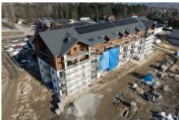
• 2025-02-10- Budowa bloku SIM na ul. Kilińskiego
