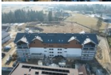
• 2025-02-10- Budowa bloku SIM na ul. Kilińskiego
