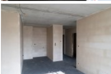
• 2025-02-10- Budowa bloku SIM na ul. Kilińskiego
