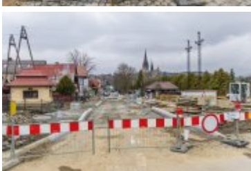
• 2025-03-27- Ulica Orkana wkrótce przejezdna
