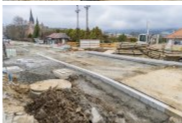
• 2025-03-27- Ulica Orkana wkrótce przejezdna
