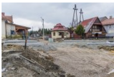
• 2025-03-27- Ulica Orkana wkrótce przejezdna
