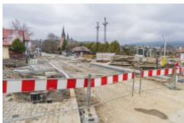
• 2025-03-27- Ulica Orkana wkrótce przejezdna
