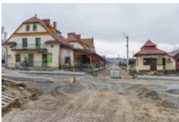
• 2025-03-27- Ulica Orkana wkrótce przejezdna
