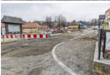
• 2025-03-27- Ulica Orkana wkrótce przejezdna
