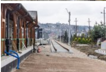
• 2025-03-27- Ulica Orkana wkrótce przejezdna
