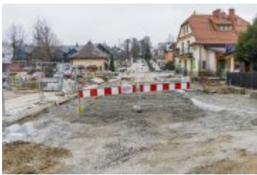
• 2025-03-27- Ulica Orkana wkrótce przejezdna
