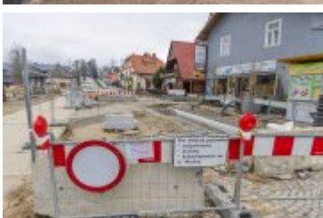
• 2025-03-27- Ulica Orkana wkrótce przejezdna
