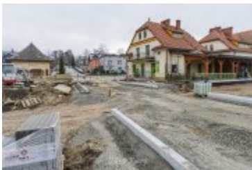
• 2025-03-27- Ulica Orkana wkrótce przejezdna
