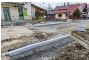
• 2025-03-27- Ulica Orkana wkrótce przejezdna
