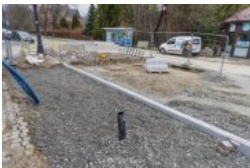
• 2025-03-27- Ulica Orkana wkrótce przejezdna
