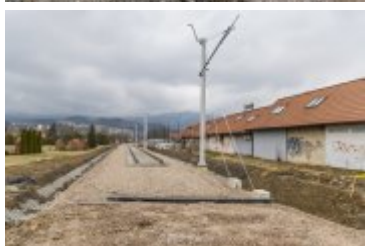
• 2025-03-27- Ulica Orkana wkrótce przejezdna
