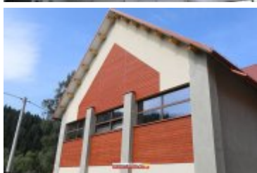
2017-08-24-Budowa sali gimnastycznej w Ponicach
