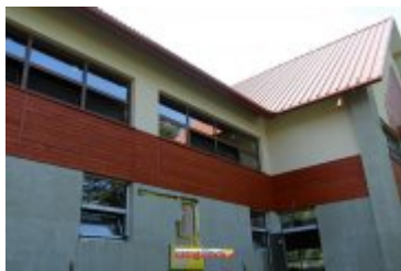
2017-08-24-Budowa sali gimnastycznej w Ponicach
