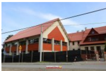
2017-08-24-Budowa sali gimnastycznej w Ponicach
