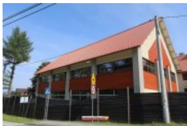
2017-08-24-Budowa sali gimnastycznej w Ponicach
