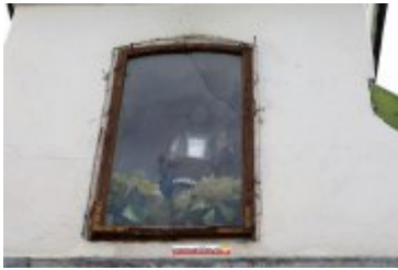
• 2017-09-12-Remont kapliczki św. Floriana przy ul. Sądeckiej
