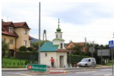
2017-09-12-Remont kapliczki św. Floriana przy ul. Sądeckiej
