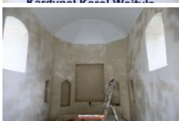
2017-09-12-Remont kapliczki św. Floriana przy ul. Sądeckiej
