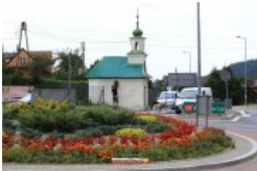
• 2017-09-12-Remont kapliczki św. Floriana przy ul. Sądeckiej
