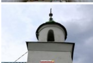
2017-09-12-Remont kapliczki św. Floriana przy ul. Sądeckiej
