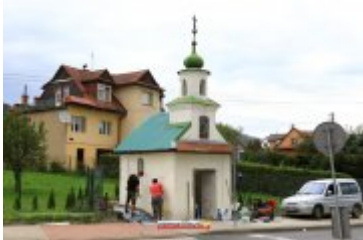
• 2017-09-12-Remont kapliczki św. Floriana przy ul. Sądeckiej
