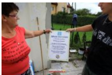
2017-09-12-Remont kapliczki św. Floriana przy ul. Sądeckiej
