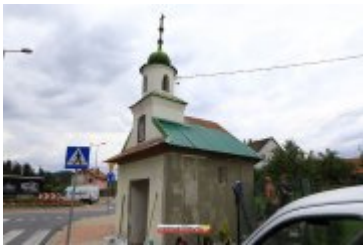
• 2017-09-12-Remont kapliczki św. Floriana przy ul. Sądeckiej
