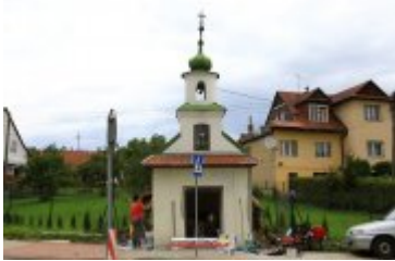
• 2017-09-12-Remont kapliczki św. Floriana przy ul. Sądeckiej
