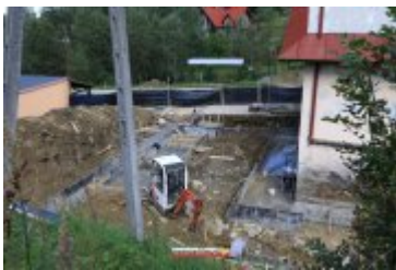
• 2017-09-13-Rozbudowa remizy OSP w Rdzawce
