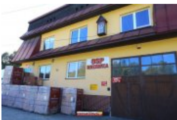
• 2017-09-13-Rozbudowa remizy OSP w Rdzawce
