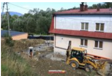
• 2017-09-13-Rozbudowa remizy OSP w Rdzawce
