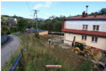
• 2017-09-13-Rozbudowa remizy OSP w Rdzawce
