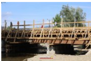
2017-09-20-Budowa mostu na Poniczance w Ponicach
