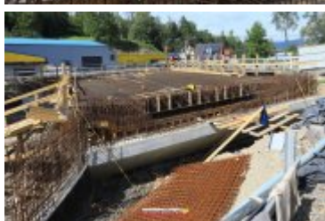
2017-09-20-Budowa mostu na Poniczance w Ponicach
