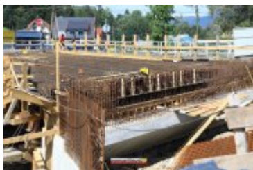
2017-09-20-Budowa mostu na Poniczance w Ponicach
