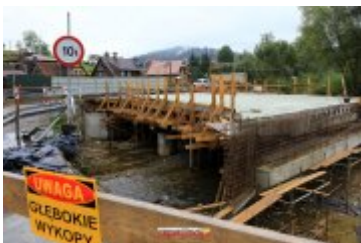
• 2017-09-20-Budowa mostu na Poniczance w Ponicach
