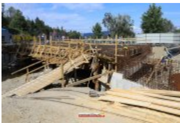
• 2017-09-20-Budowa mostu na Poniczance w Ponicach
