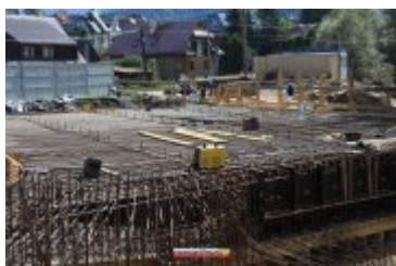
2017-09-20-Budowa mostu na Poniczance w Ponicach
