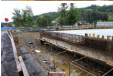
• 2017-09-20-Budowa mostu na Poniczance w Ponicach
