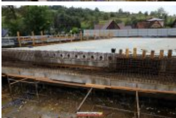
• 2017-09-20-Budowa mostu na Poniczance w Ponicach
