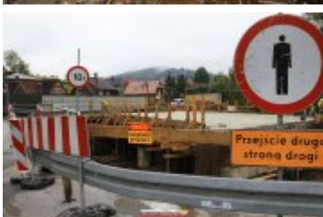
• 2017-09-20-Budowa mostu na Poniczance w Ponicach
