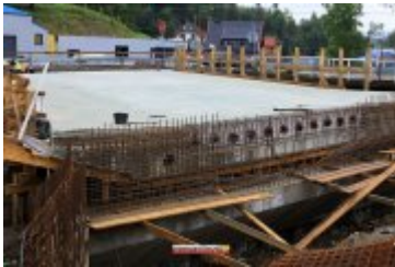
• 2017-09-20-Budowa mostu na Poniczance w Ponicach
