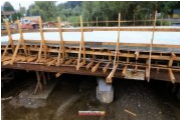
• 2017-09-20-Budowa mostu na Poniczance w Ponicach
