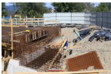
2017-09-20-Budowa mostu na Poniczance w Ponicach
