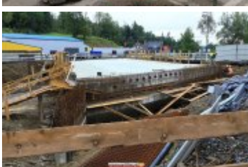
• 2017-09-20-Budowa mostu na Poniczance w Ponicach
