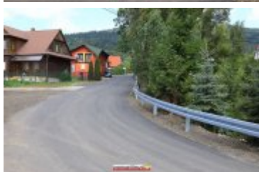
• 2017-09-21-Przebudowa drogi gminnej do oczyszczalni w Zarytem
