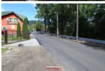
• 2017-09-21-Przebudowa drogi gminnej do oczyszczalni w Zarytem
