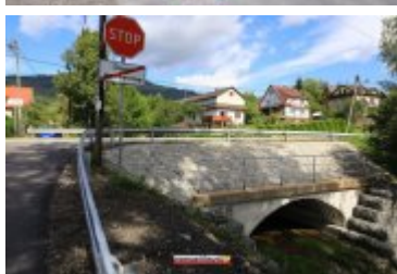
• 2017-09-21-Przebudowa drogi gminnej do oczyszczalni w Zarytem
