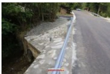
• 2017-09-21-Przebudowa drogi gminnej do oczyszczalni w Zarytem
