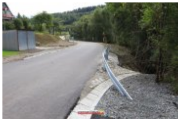
• 2017-09-21-Przebudowa drogi gminnej do oczyszczalni w Zarytem
