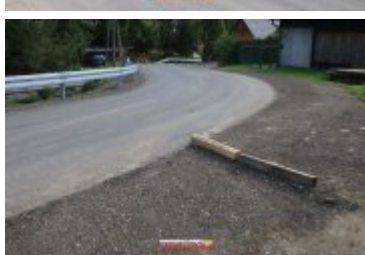
• 2017-09-21-Przebudowa drogi gminnej do oczyszczalni w Zarytem
