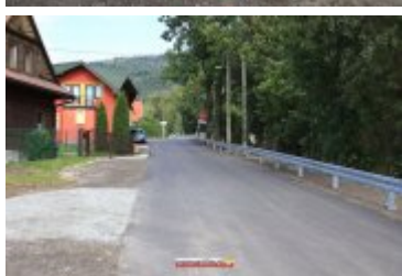
• 2017-09-21-Przebudowa drogi gminnej do oczyszczalni w Zarytem
