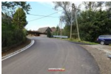
• 2017-09-21-Przebudowa drogi gminnej do oczyszczalni w Zarytem
