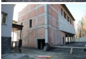
• 2017-11-17-Budowa sali gimnastycznej przy II LO
