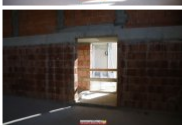
• 2017-11-17-Budowa sali gimnastycznej przy II LO
