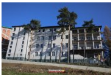
2017-11-17-Budowa sali gimnastycznej przy II LO
