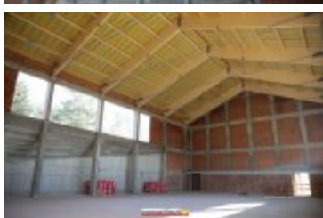
• 2017-11-17-Budowa sali gimnastycznej przy II LO
