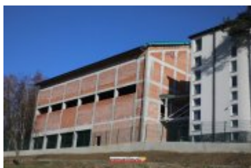
2017-11-17-Budowa sali gimnastycznej przy II LO
