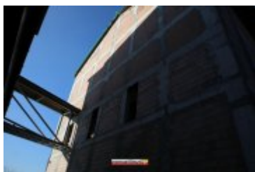
2017-11-17-Budowa sali gimnastycznej przy II LO
