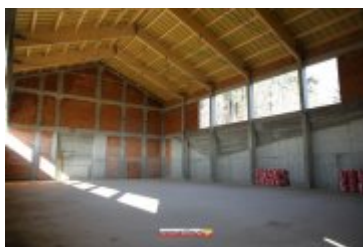
• 2017-11-17-Budowa sali gimnastycznej przy II LO
