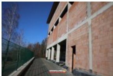
2017-11-17-Budowa sali gimnastycznej przy II LO
