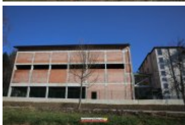
2017-11-17-Budowa sali gimnastycznej przy II LO
