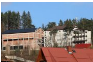
2017-11-17-Budowa sali gimnastycznej przy II LO
