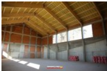
• 2017-11-17-Budowa sali gimnastycznej przy II LO
