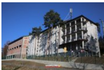
2017-11-17-Budowa sali gimnastycznej przy II LO
