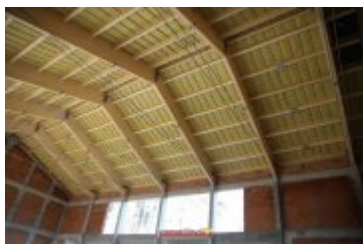
• 2017-11-17-Budowa sali gimnastycznej przy II LO
