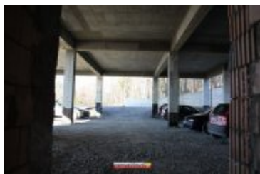
2017-11-17-Budowa sali gimnastycznej przy II LO
