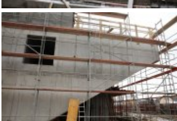
• 2018-02-21-Budowa nowego budynku Teatru Lalek Rabcio
