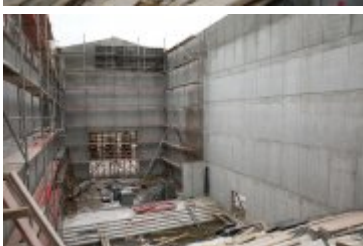
• 2018-02-21-Budowa nowego budynku Teatru Lalek Rabcio
