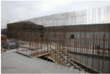
• 2018-02-21-Budowa nowego budynku Teatru Lalek Rabcio
