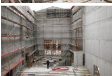
• 2018-02-21-Budowa nowego budynku Teatru Lalek Rabcio
