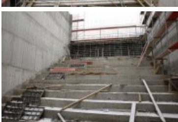
• 2018-02-21-Budowa nowego budynku Teatru Lalek Rabcio
