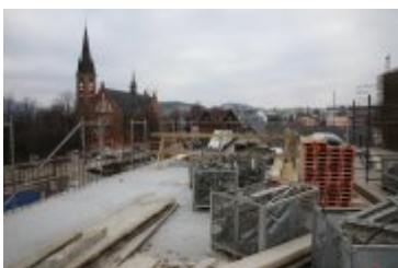
• 2018-02-21-Budowa nowego budynku Teatru Lalek Rabcio
