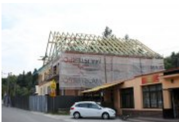
• 2018-08-09-Rozbudowa remizy OSP w Rdzawce
