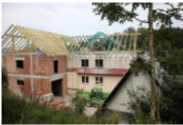
• 2018-08-09-Rozbudowa remizy OSP w Rdzawce
