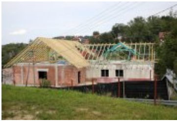
• 2018-08-09-Rozbudowa remizy OSP w Rdzawce
