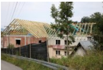
• 2018-08-09-Rozbudowa remizy OSP w Rdzawce
