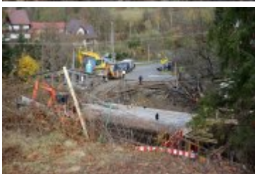
• 2018-10-26-Postępy prac na budowie mostu w Rdzawce
