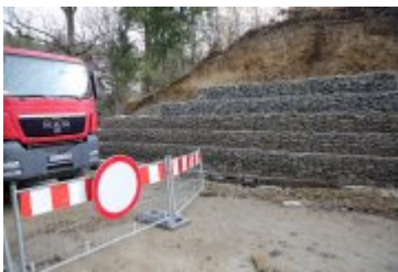
• 2018-10-26-Postępy prac na budowie mostu w Rdzawce
