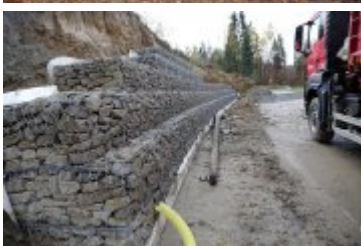
• 2018-10-26-Postępy prac na budowie mostu w Rdzawce
