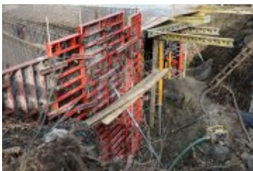
• 2018-10-26-Postępy prac na budowie mostu w Rdzawce
