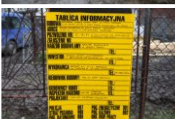
• 2018-10-26-Postępy prac na budowie mostu w Rdzawce
