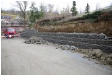
• 2018-10-26-Postępy prac na budowie mostu w Rdzawce
