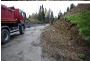
• 2018-10-26-Postępy prac na budowie mostu w Rdzawce
