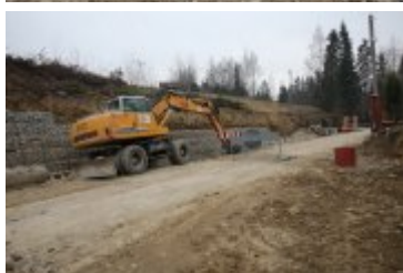
2018-11-18-Budowa mostu w Rdzawce
