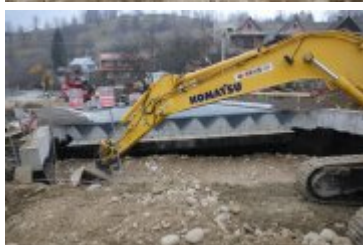
2018-11-18-Budowa mostu w Rdzawce
