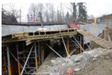
2018-11-18-Budowa mostu w Rdzawce
