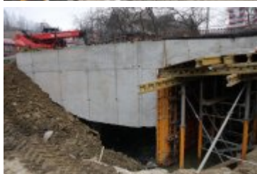
2018-11-18-Budowa mostu w Rdzawce
