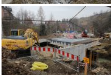
• 2018-11-18-Budowa mostu w Rdzawce
