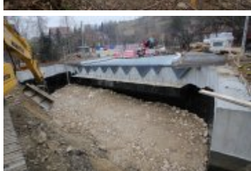
• 2018-11-18-Budowa mostu w Rdzawce
