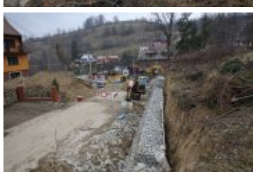
• 2018-11-18-Budowa mostu w Rdzawce
