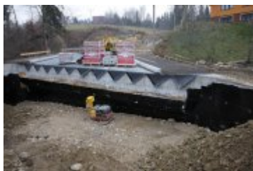
2018-11-18-Budowa mostu w Rdzawce
