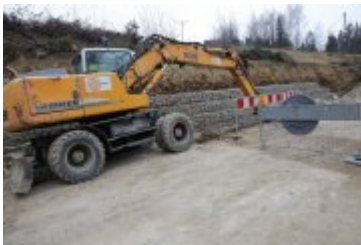
• 2018-11-18-Budowa mostu w Rdzawce
