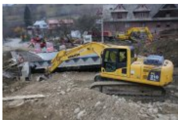
• 2018-11-18-Budowa mostu w Rdzawce
