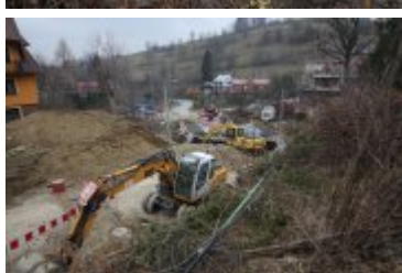
• 2018-11-18-Budowa mostu w Rdzawce
