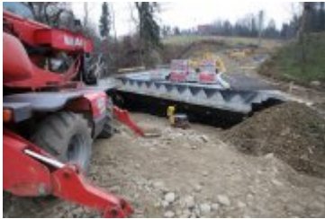
• 2018-11-18-Budowa mostu w Rdzawce
