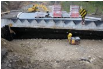
• 2018-11-18-Budowa mostu w Rdzawce
