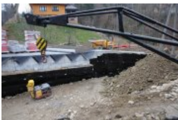
• 2018-11-18-Budowa mostu w Rdzawce
