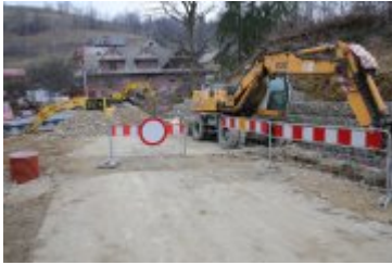
• 2018-11-18-Budowa mostu w Rdzawce
