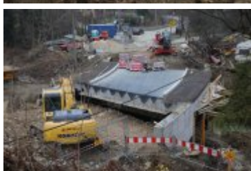
• 2018-11-18-Budowa mostu w Rdzawce
