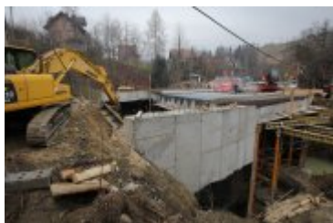
• 2018-11-18-Budowa mostu w Rdzawce
