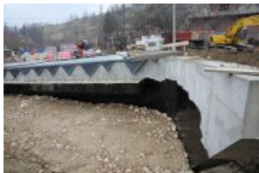
• 2018-11-18-Budowa mostu w Rdzawce
