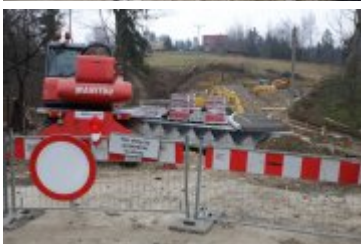
• 2018-11-18-Budowa mostu w Rdzawce
