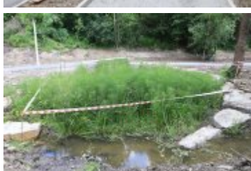
• 2019-06-24-Postępy prac na budowie bulwarów nad Poniczanką
