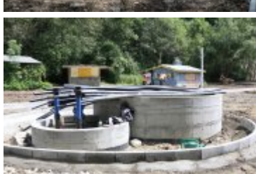
• 2019-06-24-Postępy prac na budowie bulwarów nad Poniczanką
