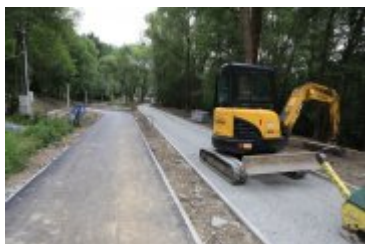
• 2019-06-24-Postępy prac na budowie bulwarów nad Poniczanką
