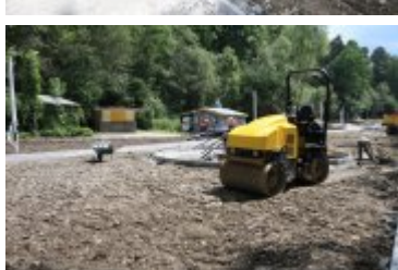
• 2019-06-24-Postępy prac na budowie bulwarów nad Poniczanką
