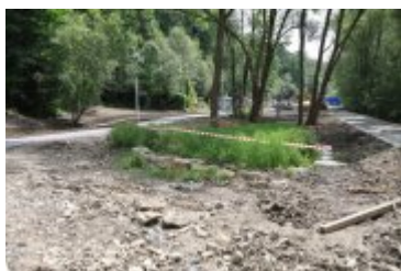
• 2019-06-24-Postępy prac na budowie bulwarów nad Poniczanką
