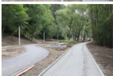
• 2019-06-24-Postępy prac na budowie bulwarów nad Poniczanką
