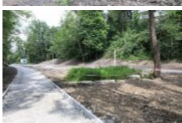
• 2019-06-24-Postępy prac na budowie bulwarów nad Poniczanką
