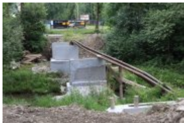
• 2019-06-24-Postępy prac na budowie bulwarów nad Poniczanką
