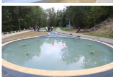
• 2019-09-02-Odbiory techniczne bulwarów nad Poniczanką
