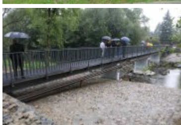
• 2019-09-02-Odbiory techniczne bulwarów nad Poniczanką
