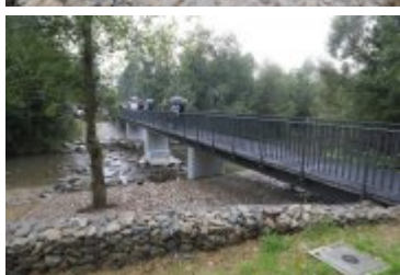
• 2019-09-02-Odbiory techniczne bulwarów nad Poniczanką
