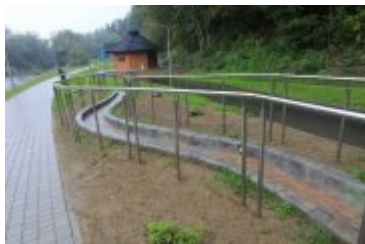
• 2019-09-02-Odbiory techniczne bulwarów nad Poniczanką
