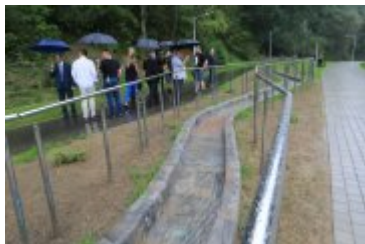
• 2019-09-02-Odbiory techniczne bulwarów nad Poniczanką
