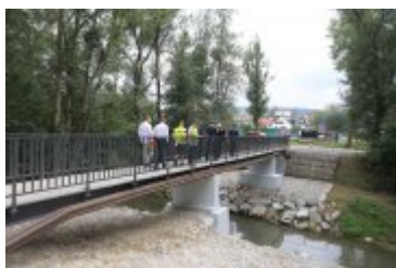
• 2019-09-02-Odbiory techniczne bulwarów nad Poniczanką
