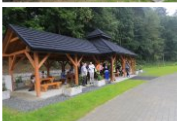
• 2019-09-02-Odbiory techniczne bulwarów nad Poniczanką
