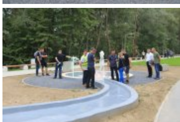
• 2019-09-02-Odbiory techniczne bulwarów nad Poniczanką
