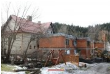
• 2017-02-24-Budowa sali gimnastycznej w Ponicach
