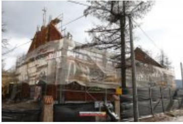
• 2017-02-24-Budowa sali gimnastycznej w Ponicach
