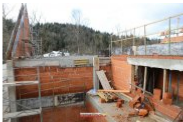
2017-02-24-Budowa sali gimnastycznej w Ponicach
