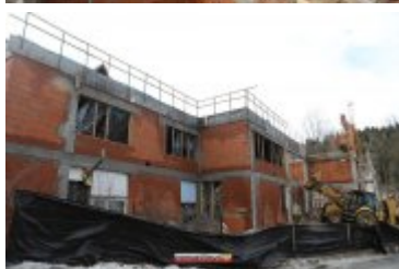
2017-02-24-Budowa sali gimnastycznej w Ponicach
