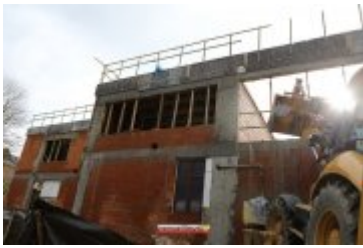
• 2017-02-24-Budowa sali gimnastycznej w Ponicach
