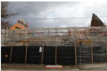
• 2017-02-24-Budowa sali gimnastycznej w Ponicach
