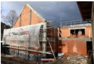
• 2017-02-24-Budowa sali gimnastycznej w Ponicach
