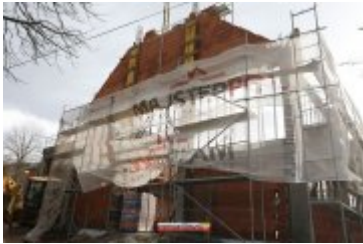
• 2017-02-24-Budowa sali gimnastycznej w Ponicach
