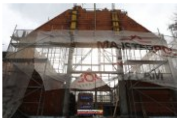
2017-02-24-Budowa sali gimnastycznej w Ponicach
