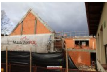
2017-02-24-Budowa sali gimnastycznej w Ponicach
