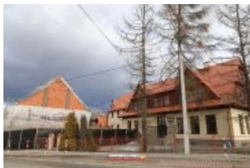
2017-02-24-Budowa sali gimnastycznej w Ponicach
