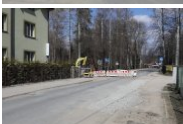
• 2020-03-19-Prace wodociągowo-kanalizacyjne na Nowym Świecie
