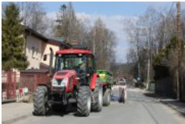
• 2020-03-19-Prace wodociągowo-kanalizacyjne na Nowym Świecie
