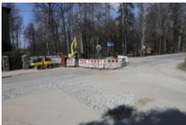
• 2020-03-19-Prace wodociągowo-kanalizacyjne na Nowym Świecie
