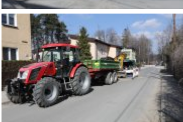
• 2020-03-19-Prace wodociągowo-kanalizacyjne na Nowym Świecie
