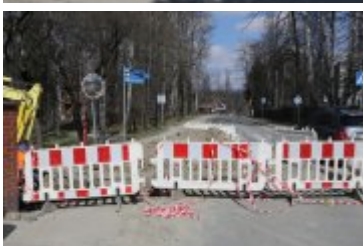
• 2020-03-19-Prace wodociągowo-kanalizacyjne na Nowym Świecie
