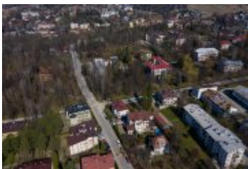
• 2020-03-19-Prace wodociągowo-kanalizacyjne na Nowym Świecie
