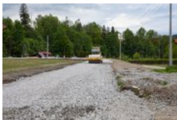
2020-06-05-Remont Stadionu Miejskiego
