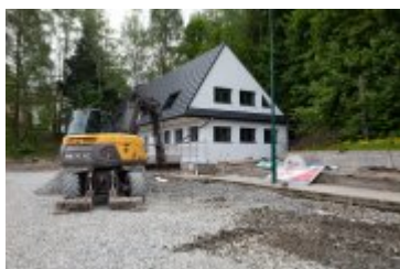
2020-06-05-Remont Stadionu Miejskiego
