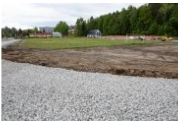
• 2020-06-05-Remont Stadionu Miejskiego
