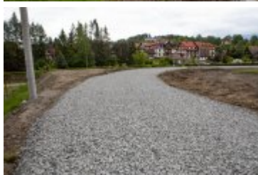
2020-06-05-Remont Stadionu Miejskiego
