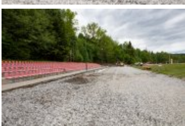
• 2020-06-05-Remont Stadionu Miejskiego
