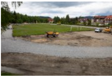
• 2020-06-05-Remont Stadionu Miejskiego
