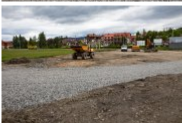
• 2020-06-05-Remont Stadionu Miejskiego
