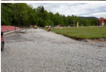
• 2020-06-05-Remont Stadionu Miejskiego
