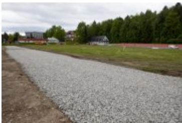
• 2020-06-05-Remont Stadionu Miejskiego
