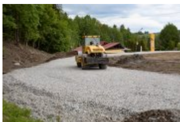
2020-06-05-Remont Stadionu Miejskiego
