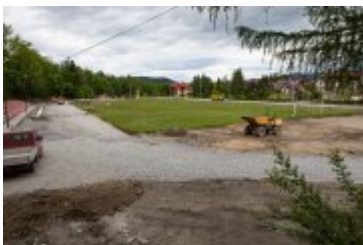
• 2020-06-05-Remont Stadionu Miejskiego
