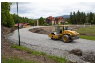
2020-06-05-Remont Stadionu Miejskiego
