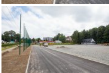
• 2020-08-06-Postępy prac na stadionie miejskim
