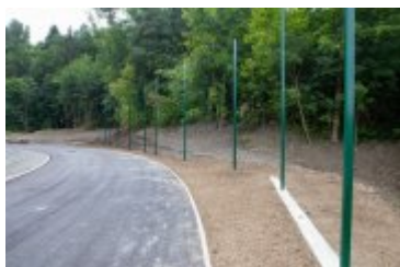
• 2020-08-06-Postępy prac na stadionie miejskim
