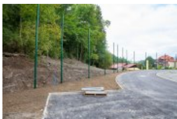
• 2020-08-06-Postępy prac na stadionie miejskim
