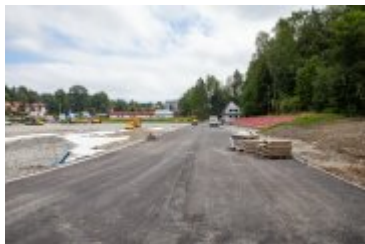
• 2020-08-06-Postępy prac na stadionie miejskim
