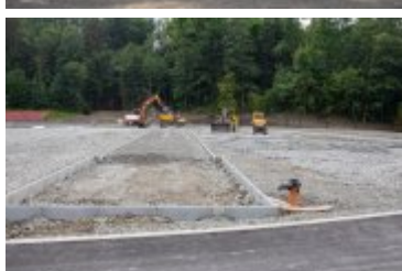
• 2020-08-06-Postępy prac na stadionie miejskim
