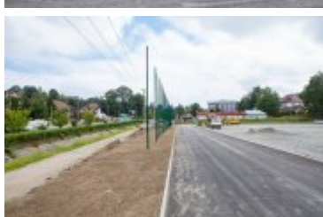
• 2020-08-06-Postępy prac na stadionie miejskim
