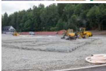
• 2020-08-06-Postępy prac na stadionie miejskim
