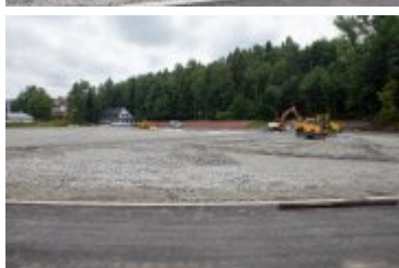
• 2020-08-06-Postępy prac na stadionie miejskim
