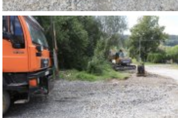
• 2020-08-21-Remont drogi osiedlowej na Traczykówc
