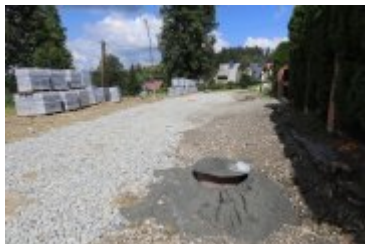
• 2020-08-21-Remont drogi osiedlowej na Traczykówc
