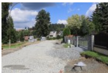
• 2020-08-21-Remont drogi osiedlowej na Traczykówc
