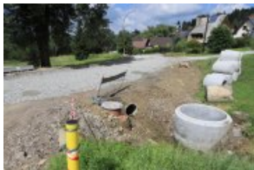
• 2020-08-21-Remont drogi osiedlowej na Traczykówc
