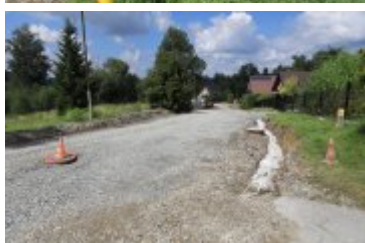
• 2020-08-21-Remont drogi osiedlowej na Traczykówc
