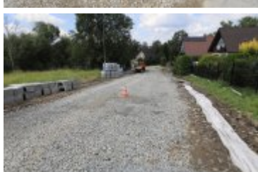
• 2020-08-21-Remont drogi osiedlowej na Traczykówc
