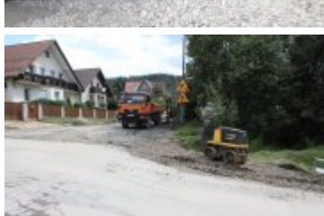
• 2020-08-21-Remont drogi osiedlowej na Traczykówc
