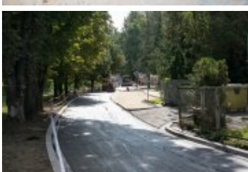
• 2020-08-25-Układanie dywanika asfaltowego na Alei Tysiąclecia
