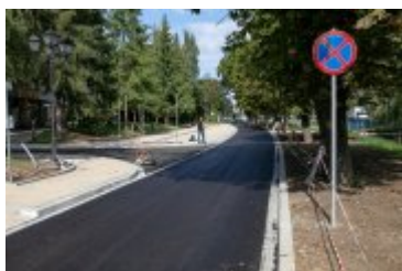
2020-08-25-Układanie dywanika asfaltowego na Alei Tysiąclecia
