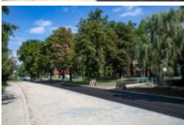
• 2020-08-25-Układanie dywanika asfaltowego na Alei Tysiąclecia
