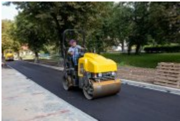
• 2020-08-25-Układanie dywanika asfaltowego na Alei Tysiąclecia
