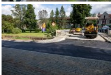
2020-08-25-Układanie dywanika asfaltowego na Alei Tysiąclecia
