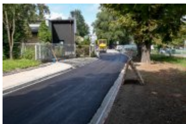
2020-08-25-Układanie dywanika asfaltowego na Alei Tysiąclecia
