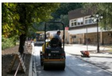
2020-08-25-Układanie dywanika asfaltowego na Alei Tysiąclecia
