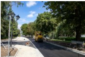
• 2020-08-25-Układanie dywanika asfaltowego na Alei Tysiąclecia
