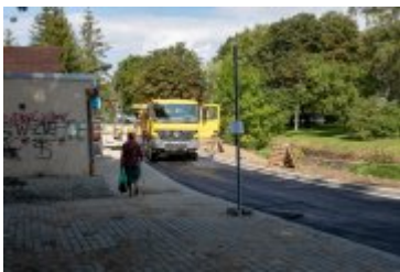
• 2020-08-25-Układanie dywanika asfaltowego na Alei Tysiąclecia
