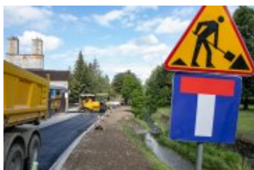
2020-08-25-Układanie dywanika asfaltowego na Alei Tysiąclecia
