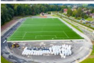
• 2020-09-25-Modernizacja stadionu miejskiego
