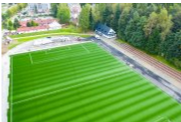
• 2020-09-25-Modernizacja stadionu miejskiego
