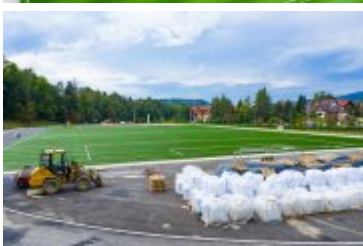
• 2020-09-25-Modernizacja stadionu miejskiego
