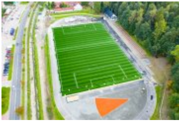
• 2020-09-25-Modernizacja stadionu miejskiego
