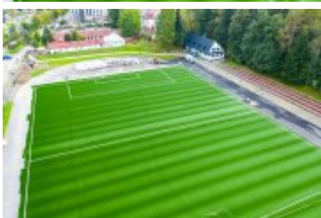
• 2020-09-25-Modernizacja stadionu miejskiego
