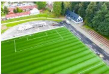
• 2020-09-25-Modernizacja stadionu miejskiego
