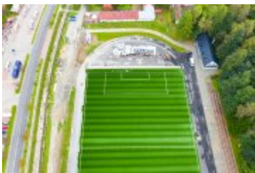
• 2020-09-25-Modernizacja stadionu miejskiego
