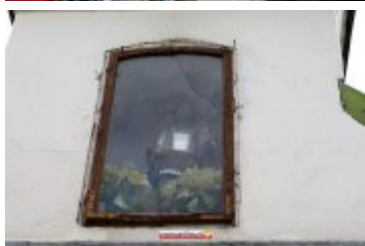
• 2017-09-12-Remont kapliczki św. Floriana przy ul. Sąddeckiej
