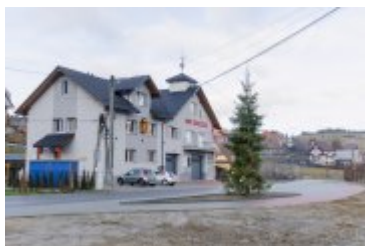
• 2024-01-05-Budowa parkingu obok remizy OSP w Rdzawce
