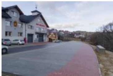
• 2024-01-05-Budowa parkingu obok remizy OSP w Rdzawce
