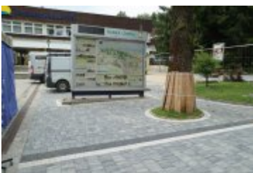
• 2023-08-29-Remont rabczańskiego deptaka
