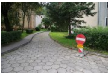
• 2023-08-22-Przebudowa drogi osiedlowej przy ul. Chopina
