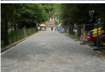
• 2023-08-29-Remont rabczańskiego deptaka
