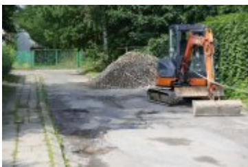
• 2023-08-22-Przebudowa drogi osiedlowej przy ul. Chopina
