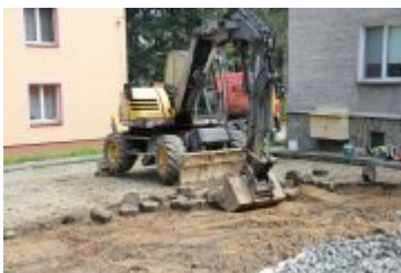
• 2023-08-22-Przebudowa drogi osiedlowej przy ul. Chopina
