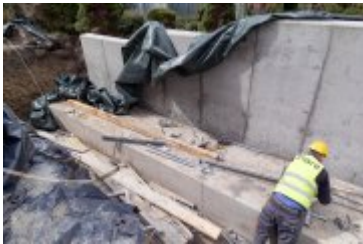
• 2024-03-28-Postępy prac na budowie szpitala
