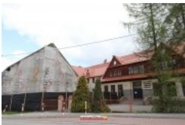
• 2017-05-09-Budowa sali gimnastycznej w Ponicach
