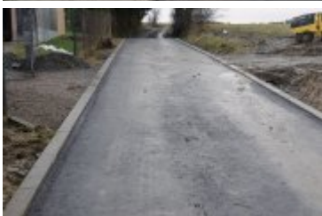
• 2024-01-03-Remont ulicy Bystrej
