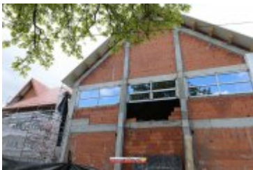
• 2017-05-09-Budowa sali gimnastycznej w Ponicach
