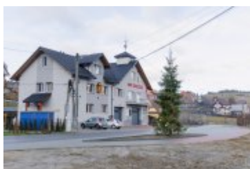
• 2024-01-05-Budowa parkingu obok remizy OSP w Rdzawce
