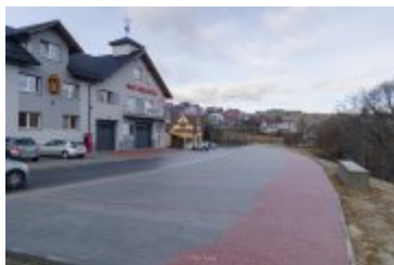
• 2024-01-05-Budowa parkingu obok remizy OSP w Rdzawce
