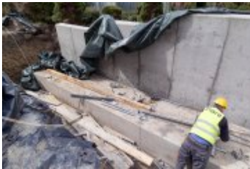
• 2024-03-28-Postępy prac na budowie szpitala
