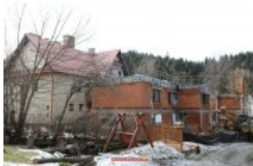
2017-02-24-Budowa sali gimnastycznej w Ponicach
