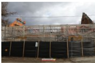
2017-02-24-Budowa sali gimnastycznej w Ponicach
