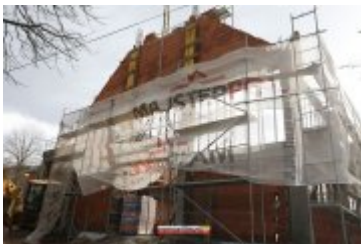
• 2017-02-24-Budowa sali gimnastycznej w Ponicach
