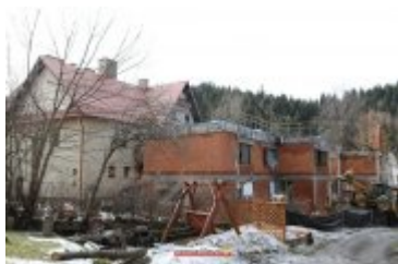
• 2017-02-24-Budowa sali gimnastycznej w Ponicach
