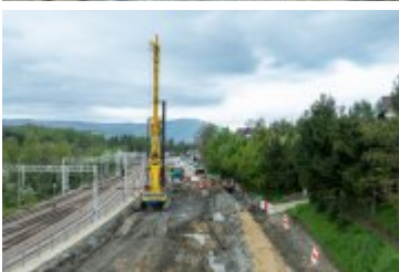
• 2024-04-17-Palowanie osuwiska na ul. Zakopiańskiej
