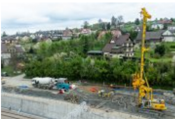
• 2024-04-17-Palowanie osuwiska na ul. Zakopiańskiej
