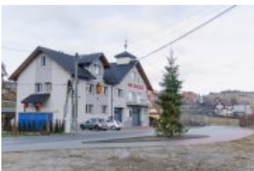
2024-01-05-Budowa parkingu obok remizy OSP w Rdzawce
