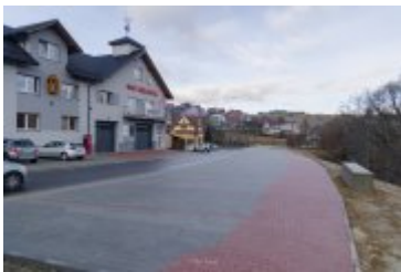
2024-01-05-Budowa parkingu obok remizy OSP w Rdzawce
