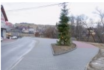
2024-01-05-Budowa parkingu obok remizy OSP w Rdzawce
