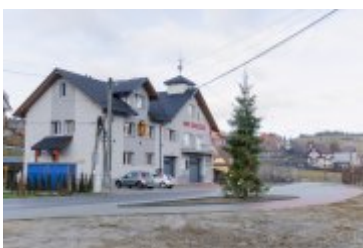
2024-01-05-Budowa parkingu obok remizy OSP w Rdzawce
