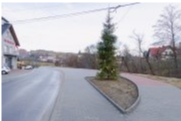
2024-01-05-Budowa parkingu obok remizy OSP w Rdzawce
