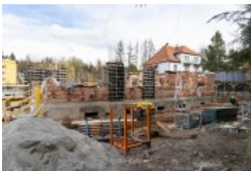
• 2024-03-28-Postępy prac na budowie szpitala
