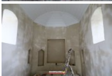
• 2017-09-12-Remont kapliczki św. Floriana przy ul. Sądeckiej
