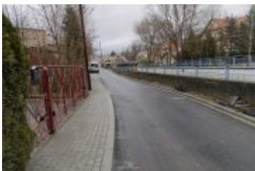
• 2024-01-03-Remont ulicy Bystrej
