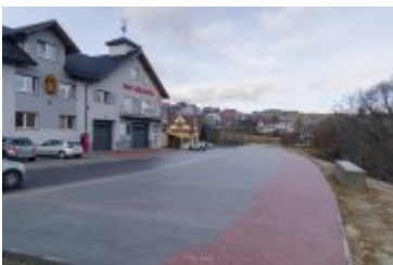
2024-01-05-Budowa parkingu obok remizy OSP w Rdzawce
