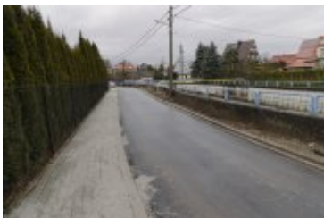
• 2024-01-03-Remont ulicy Bystrej
