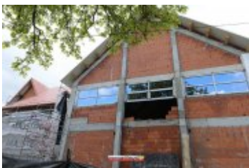
• 2017-05-09-Budowa sali gimnastycznej w Ponicach
