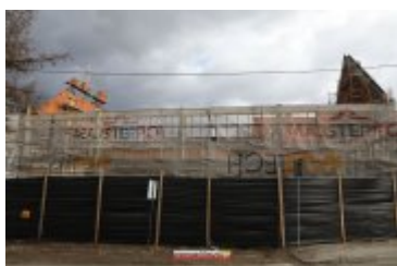
2017-02-24-Budowa sali gimnastycznej w Ponicach
