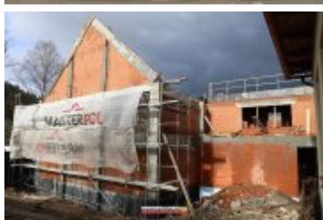
2017-02-24-Budowa sali gimnastycznej w Ponicach
