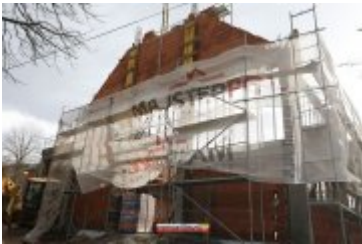
• 2017-02-24-Budowa sali gimnastycznej w Ponicach
