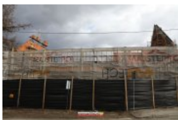
2017-02-24-Budowa sali gimnastycznej w Ponicach
