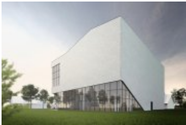
• 2017-06-29-Rozpoczęcie budowy budynku teatru Rabcio
