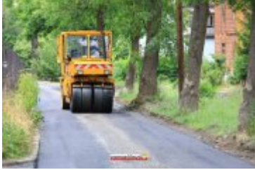
• 2017-06-30-Nowa nawierzchnia na Alei Tysiąclecia
