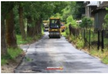
• 2017-06-30-Nowa nawierzchnia na Alei Tysiąclecia
