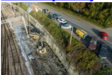
• 2023-10-23-Stabilizacja muru i skarpy mikropalami przy osuwisku na ul. Zakopiańskiej
