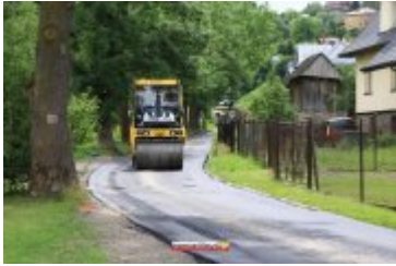
• 2017-06-30-Nowa nawierzchnia na Alei Tysiąclecia
