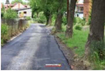
• 2017-06-30-Nowa nawierzchnia na Alei Tysiąclecia
