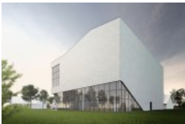
• 2017-06-29-Rozpoczęcie budowy budynku teatru Rabcio
