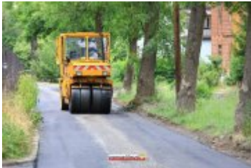
• 2017-06-30-Nowa nawierzchnia na Alei Tysiąclecia
