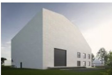
• 2017-06-29-Rozpoczęcie budowy budynku teatru Rabcio
