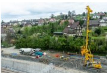
• 2024-04-17-Palowanie osuwiska na ul. Zakopiańskiej
