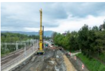
• 2024-04-17-Palowanie osuwiska na ul. Zakopiańskiej
