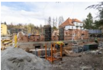
2024-03-28-Postępy prac na budowie szpitala
